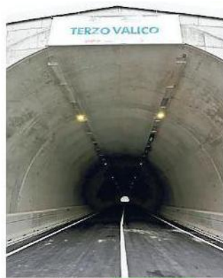
Una galleria del Terzo Valico
