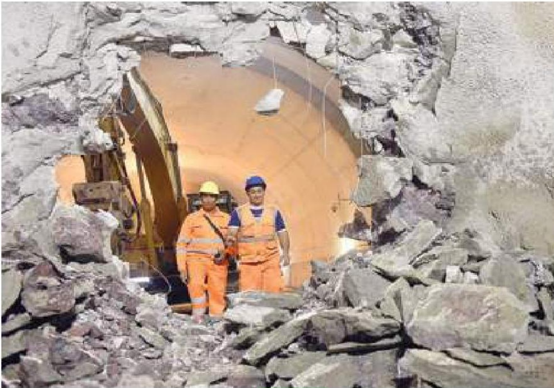
Lavoratori impegnati nella realizzazione del Terzo valico fra Liguria e Piemonte
