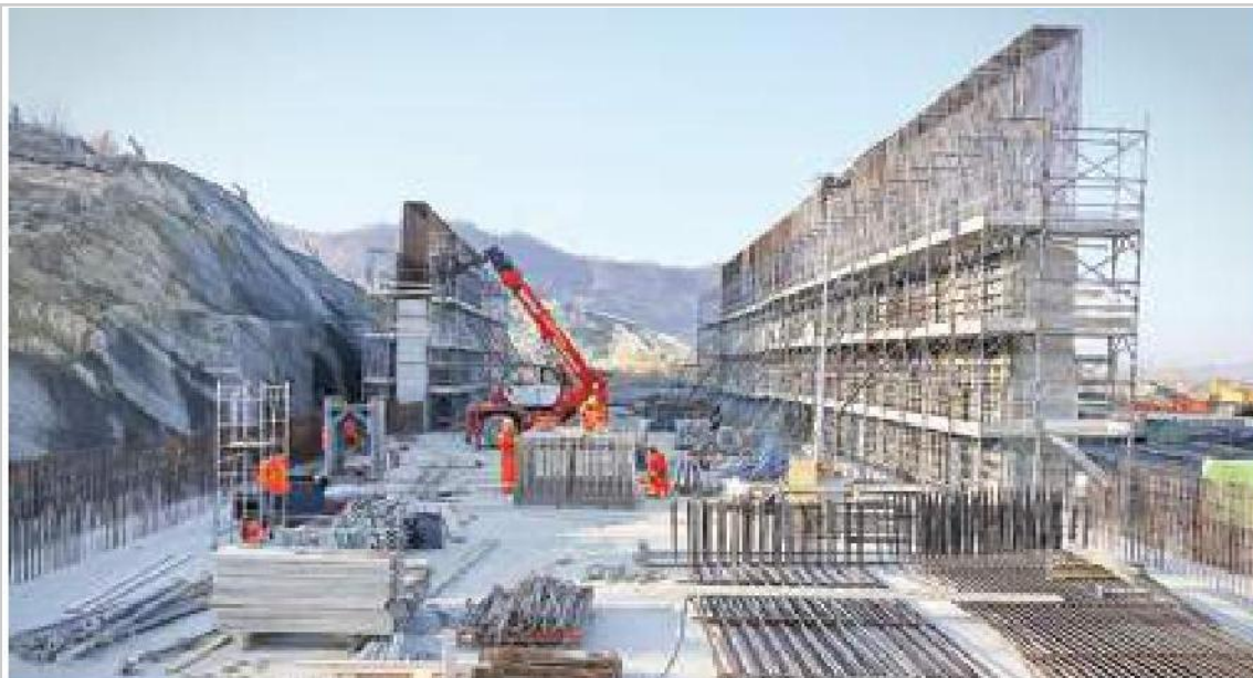
Terzo Valico , da assegnare rimangono ancora appalti per 900 milioni di euro
