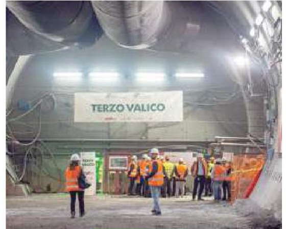
Uno dei cantieri del Terzo valico dei Giovi
