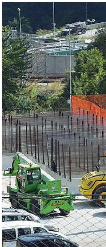
Attività al cantiere della Torino-Lione a Chiomonte
