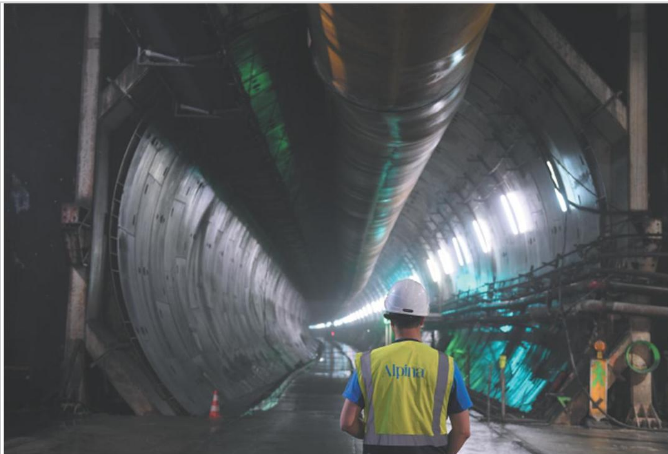
I lavori sul versante francese sono quasi al termine: scavati oltre 8.100 metri sui circa 8.700 del tunnel
