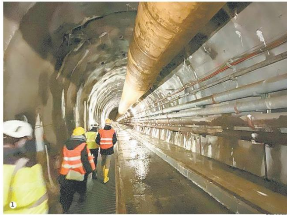
1. Nella parte di tunnel già scavata tra un paio di mesi tornano gli operai: ci sono da scavare 23 nicchie per le manovre dei mezzi da cantiere. 2. 3. Si preparano le aree di lavoro 4. Qui sarà costruito lo svincolo autostradale di ingresso e di uscita dall'area di lavoro
