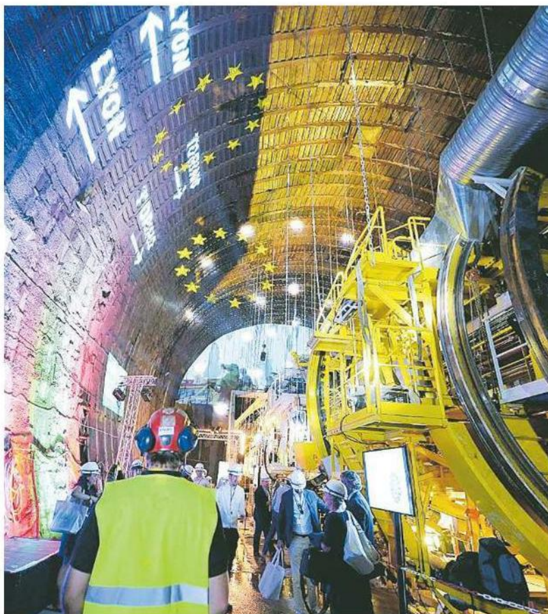
▲ Al via il tunnel italiano Nei prossimi mesi cominceranno i lavori anche in val di Susa
